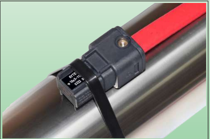
电缆插入拧紧并安装在管道上
